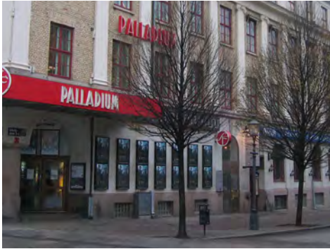
Kv. Bastionen, Göteborg, före ombyggnad
