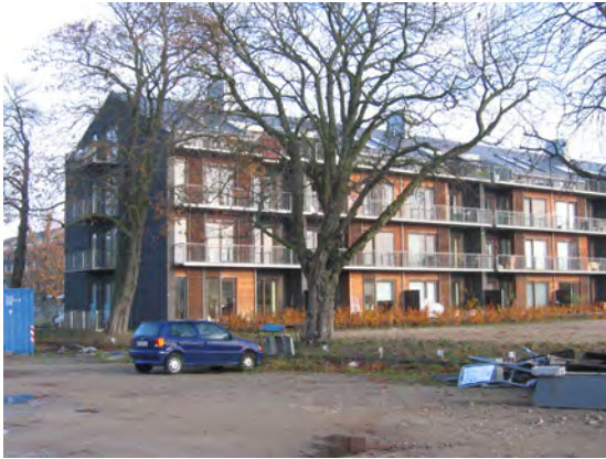
Balkonger halvt infällda i byggnadsvolymen på bostadshus i Köpenhamn
