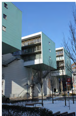
Påbyggnad med bostäder på P-hus, Göteborg
