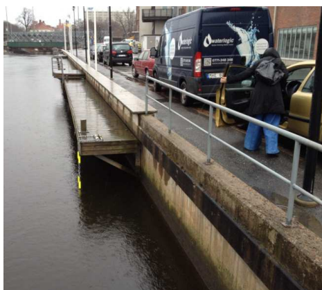
Foto 1. Betongkaj i bra skick.
