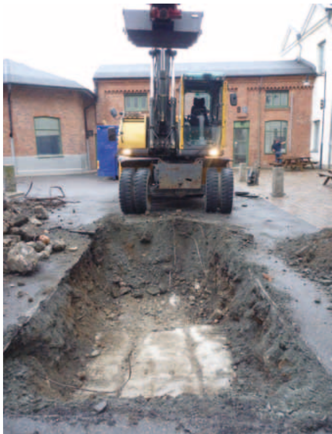
Illustration 16. Foto av schakt 3 mot väster. På den västra innergården kunde schakten inte grävas till botten på grund av äldre betonggolv och ledningar.
