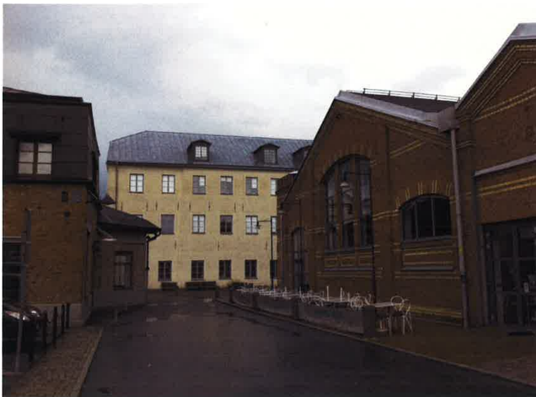
Bild 3: Den beigea byggnaden, B1, uppförd som sockerbruk 1733.
