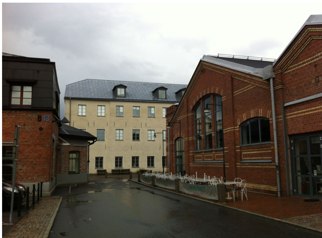
Bild 3: Den beigea byggnaden, B1, uppförd som sockerbruk 1733.
