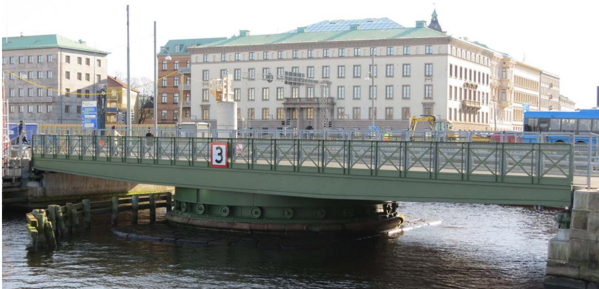
Stora Bommens bro är idag endast en kuliss med en ny brokonstruktion inuti. Svängmekaniken är inte intakt. Foto © Ida Dicksson 2019
