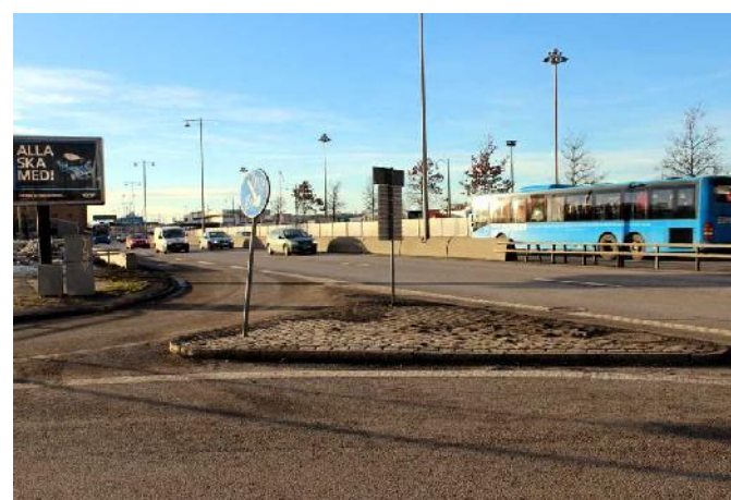
I områdets västra delar ligger Oscarsleden i direkt anslutning till Östra Sänkverksgatan, som ett öppet sår i stadslandskapet.
