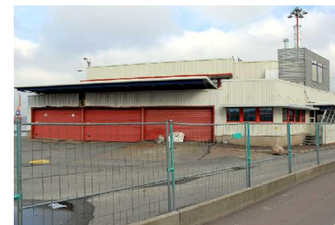
Kajskjul 30 alldeles innan rivning i april 2015.
