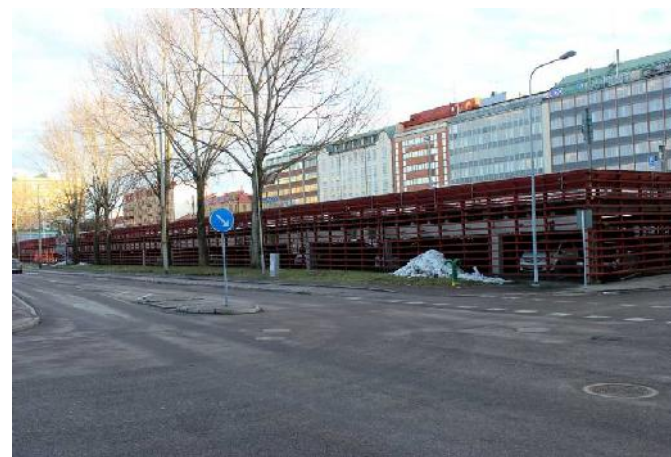
Parkeringshus i två våningar i kvarteret Snipan.
