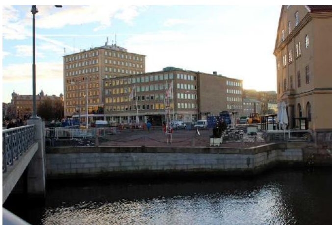
Folkets hus östra och norra fasader från 1950-talet.
