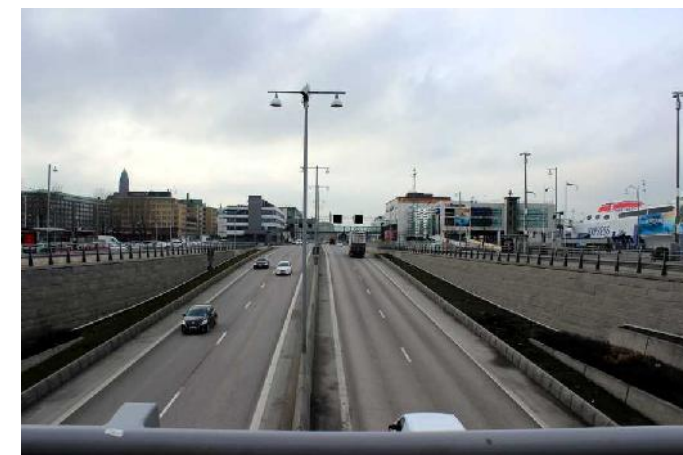
Den brutala öppningen med de breda bilvägarna skapar en kraftig barriär, här ovanför en av Götatunnelns uppfarter.
