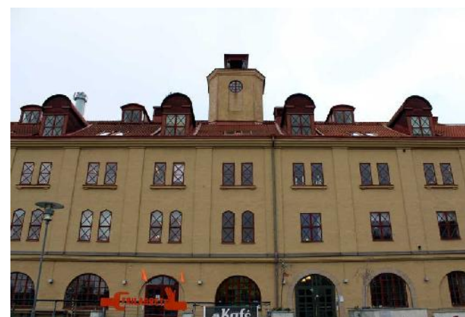
Frilagerhusets västra fasad - detalj.
