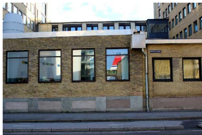
Detalj där byggnaderna möts från 1940 och 1950-talen.
