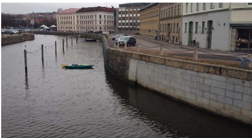
Foto 1. Två olika typer av kajmurar utmed Rosenlundskanalen.
