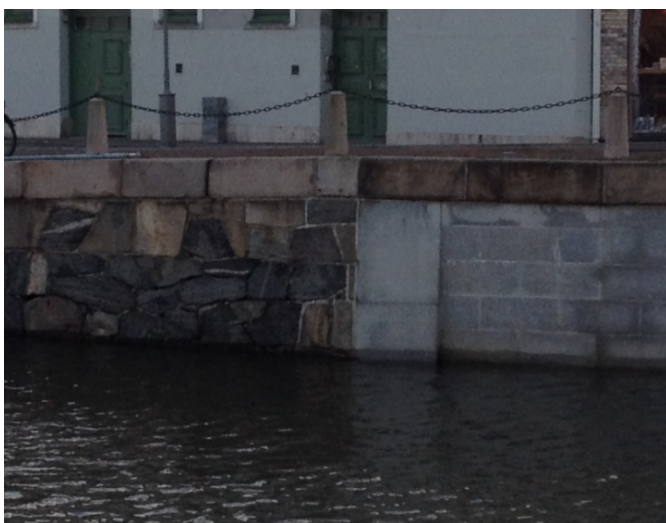
Foto 3. Anslutning mellan ny och äldre kajmur i öster
