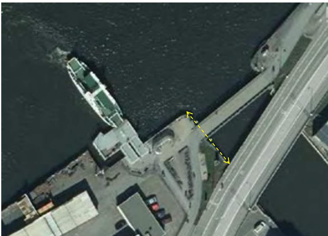
Figur 56. Sträcka där befintlig kaj renoveras och höjs
