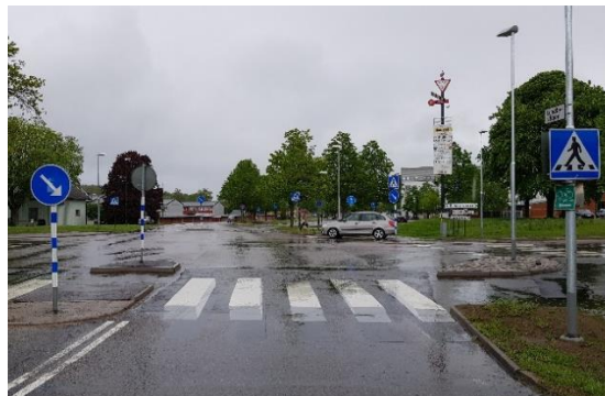
Figur 10a: Exempel från Lerum där ett övergångsställe utformats med 3D-effekt för att bilförare ska hålla hastighetsbegränsningen i området.
