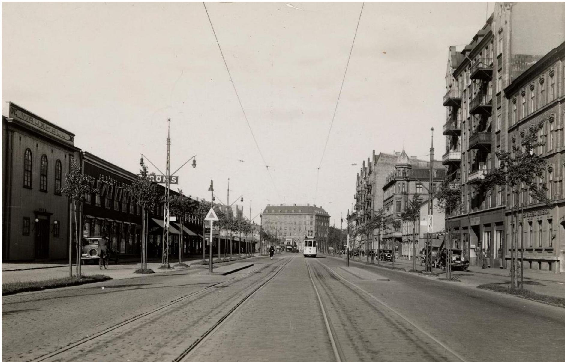
Första Långgatan, vy mot öster och Järntorget. Den småskaliga fastighetsindelningen och långsamma utbyggnadstakten resulterade i en mångfald av arkitektoniska stilar och utformningar. (Göteborgs stadsmuseum)
