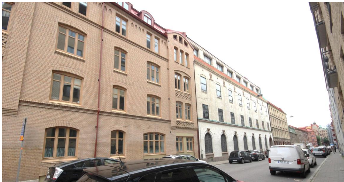
Vy mot delar av kvarteret Barken där Fjärde Långgatans äldsta byggnader finns. Några av dem är föremål för rivning. Den vitslammade tegelbyggnaden är före detta Telegrafverket från 1919.
