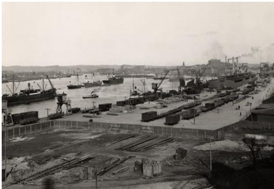
Fotografi från 1921. Strandremsan vid älven är inte längre uppstyckad i mindre hamnar utan är utjämnad till en modern kajanläggning. (Göteborgs Stadsmuseum)
