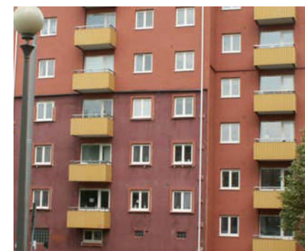
5. Borttagen tilläggsisoleringen på ett av punkthusen på Kabelgatan 2010.
