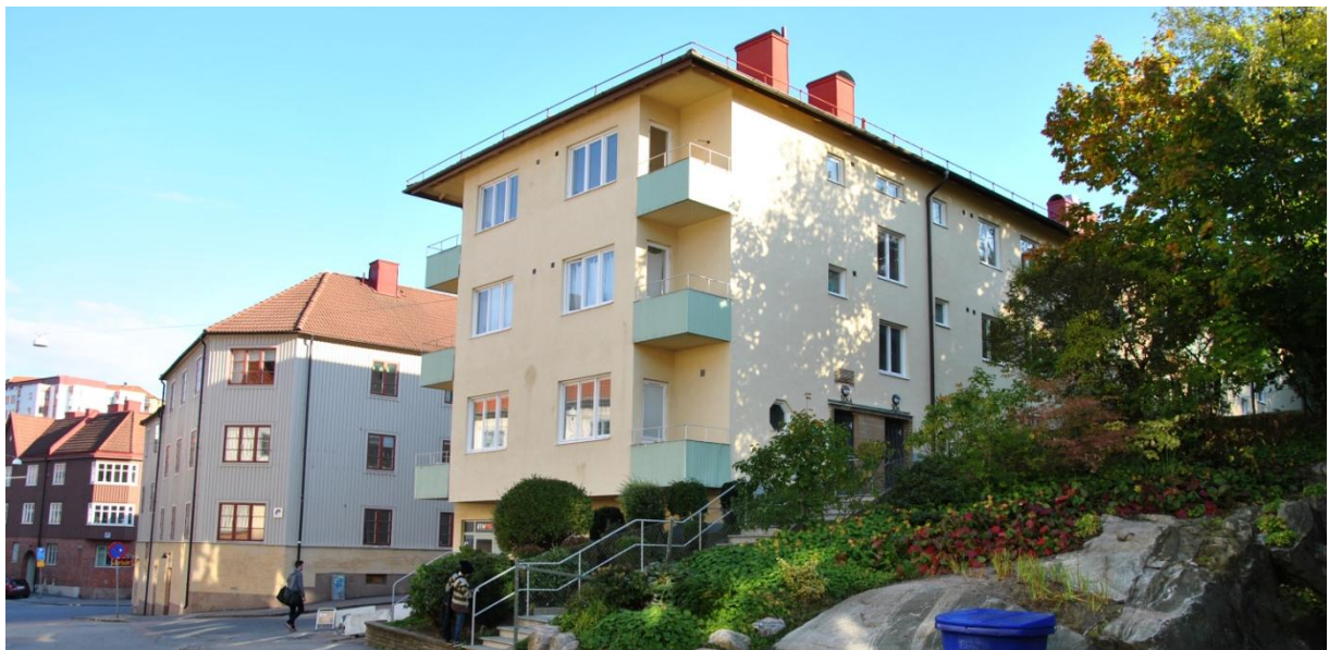
Vy utmed Koopmansgatan i östlig riktning. Illustrerar 1940-talets varsamma bostadskopplettering närmast till höger i bild.
