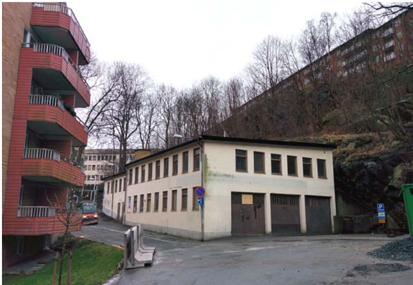
Byggnad inom planområdet med garage och verksamheter. Bostadshuset Borgen skymtas ovanför på berget.
