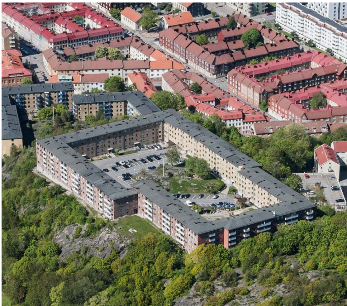
Flygfoto över Godhemsberget taget från sydväst. Norr om kvarteret Borgen syns Majornas äldre kvartersstruktur vilken ingår i Göteborgs Stads bevarandeprogram.
