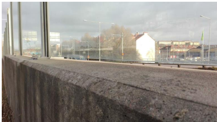
Figur 3. Horisontell glipa i skärmkonstruktion Oscarsleden. Bild från Reinertsens rapport.
