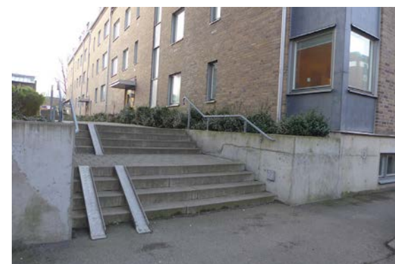
I det moderna bostadsområdet är gatumiljön enkelt utformad med asfalterade ytor, gjutna trappor och räcken av förzinkat stål.
