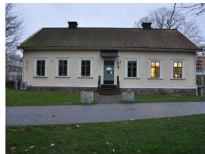
Kungsladugårdens manbyggnad, ritades av Göteborgs stadsarkitekt H.J. Strömberg år 1863.
