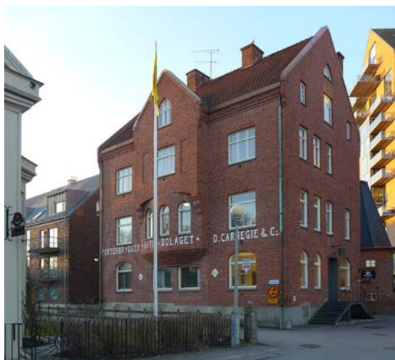
Tegelbyggnad från 1800-talet tillhörande Carnegiebrukets porterbryggeri.
