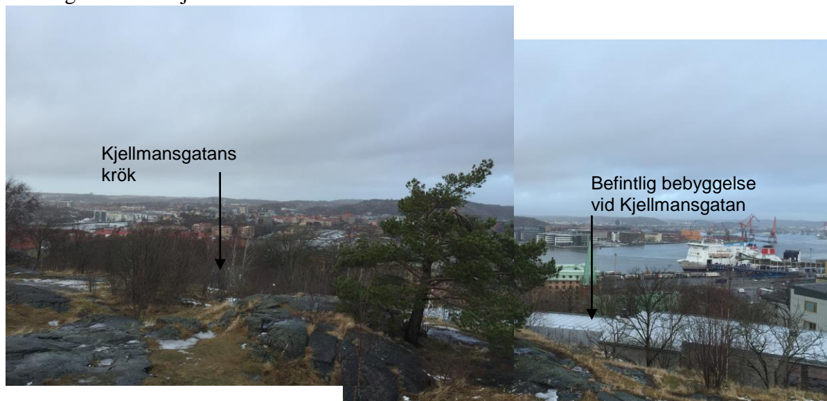
Figur 37 Vy från bergets högsta punkt mot planområdet. Till höger i bild anas taket på befintlig bebyggelse vid Kjellmansgatan 7 (4 våningar). Kjellmansgatans krök gömmer sig bakom växtligheten i bilden och markeras med en pil.
