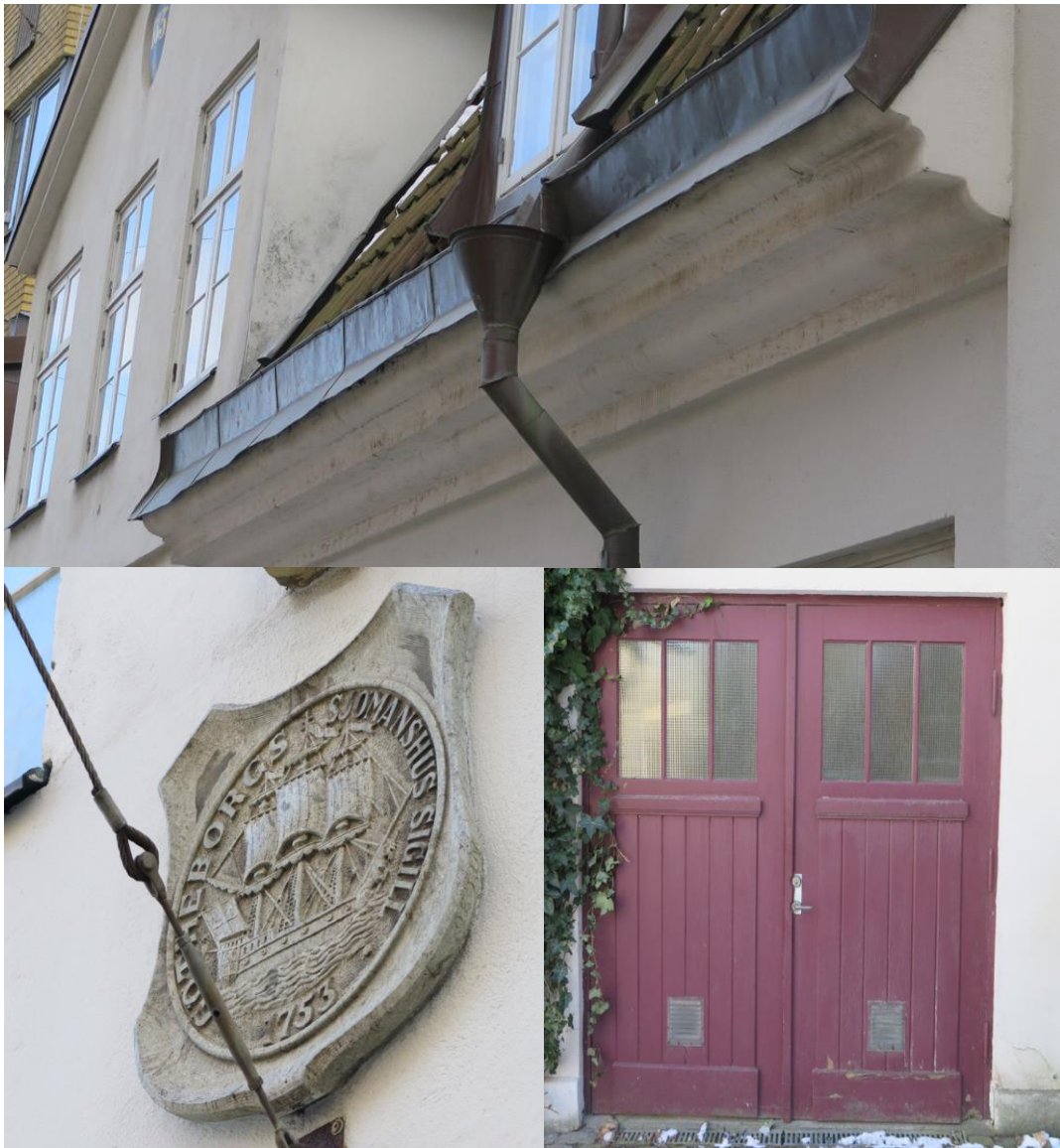
Figur 10 Överst, profilerad taklist mot gatufasaden, till vänster sigill mot gatan anno 1753, till höger garageport mot gården från 1930-talet.
