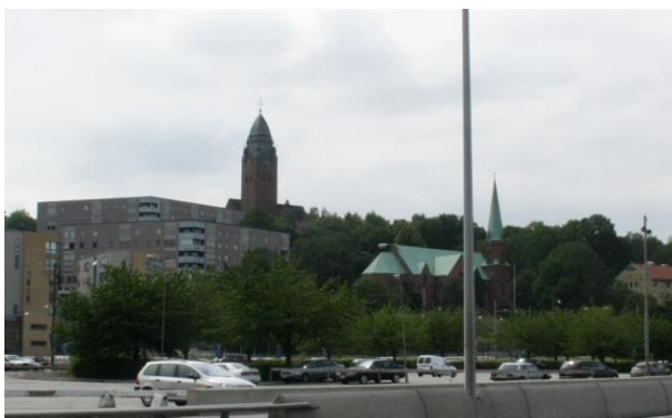
Figur 32 Från Stena Danmarksterminal. Endast kyrkans tak och delar av tak framträder ovan en förgrund av byggnader.
