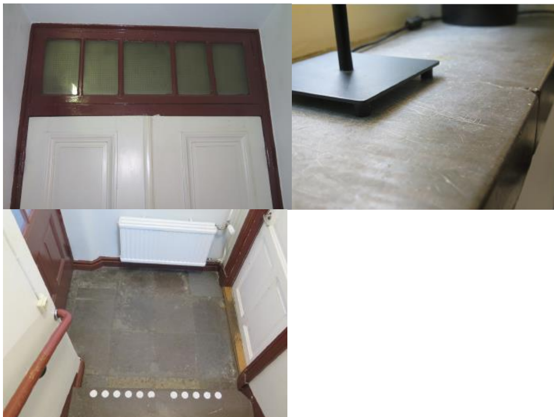
Figur 11 Inbyggd huvudentré, fönsterbänk i kalksten, trapphus med bevarat stengolv samt snickerier.
