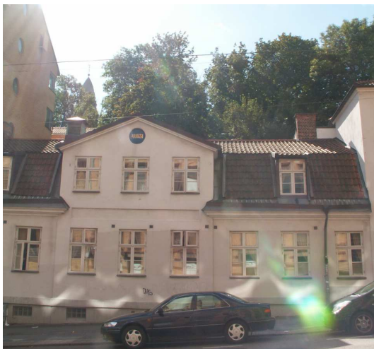
Masthuggskyrkans torn sedd från Stigbergssliden
