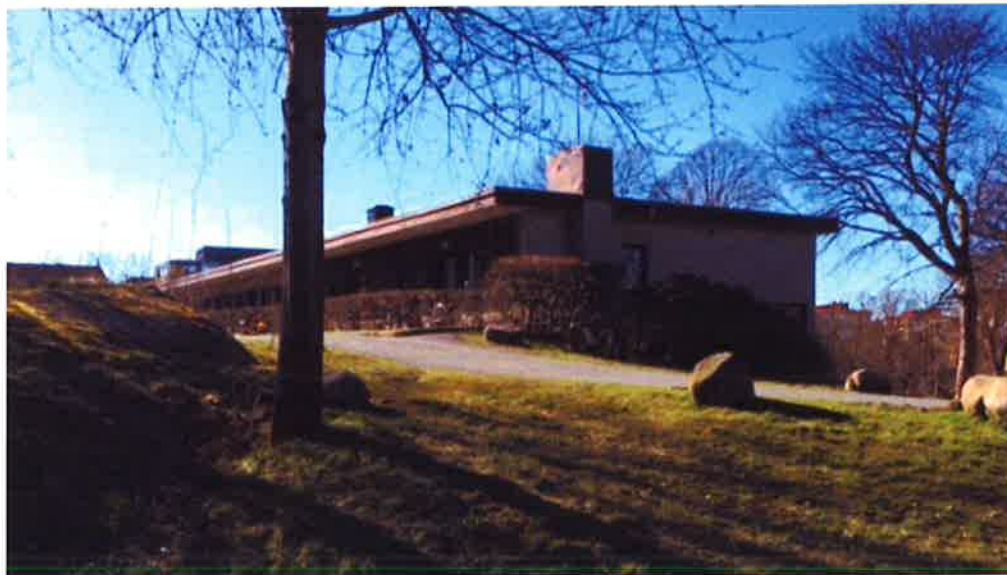
Byggnad med befintligt boende och daglig verksamhet.
