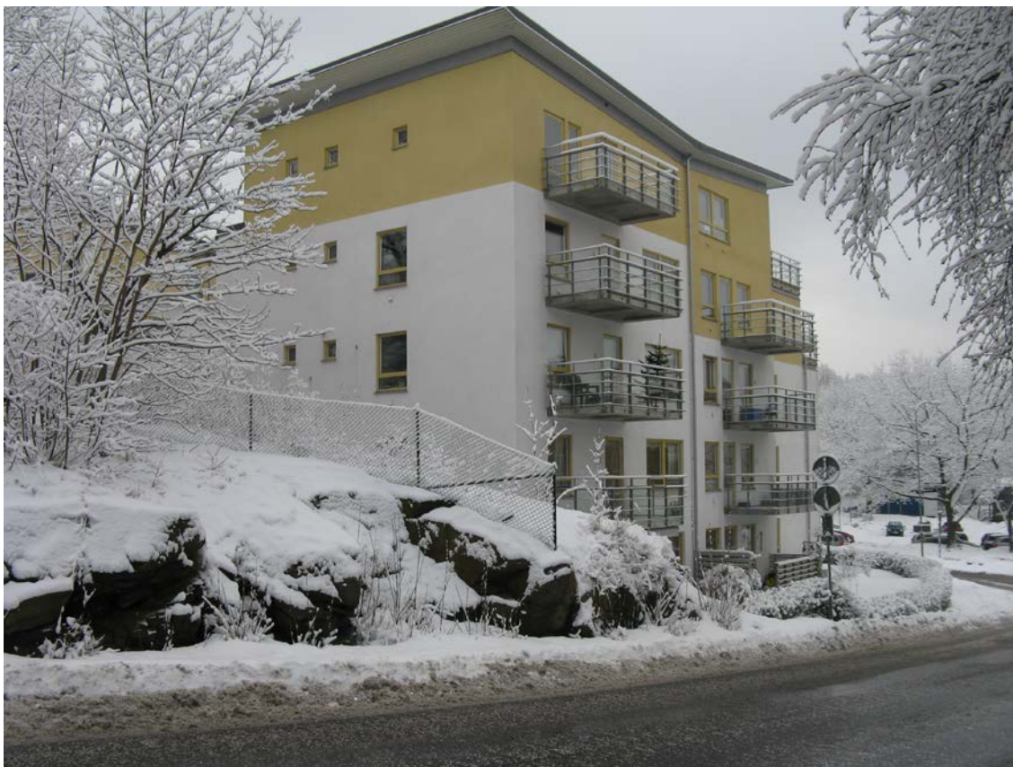
Befintligt punkthus längst ner på Ulfspärregatan
