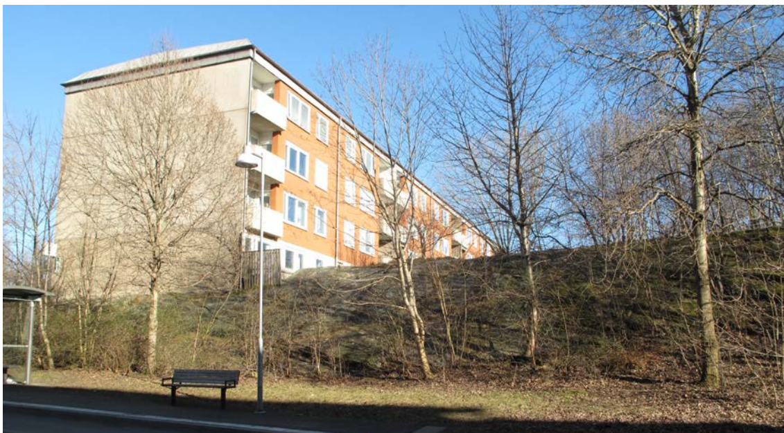
Befintlig fasad, utan fönster mot Ulfspärregatan
