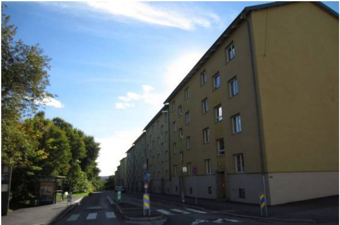
Befintliga lamellhus längs Ulfsparrégatan
