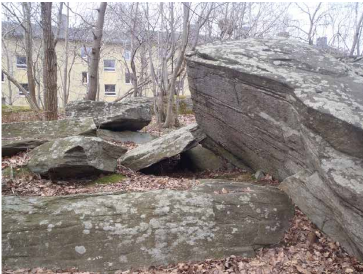
Foto 14. Uppallade lösliggande block vid den stora asfaltytan. Blocken bedöms idag vara stabila. Bild tagen mot väst.
