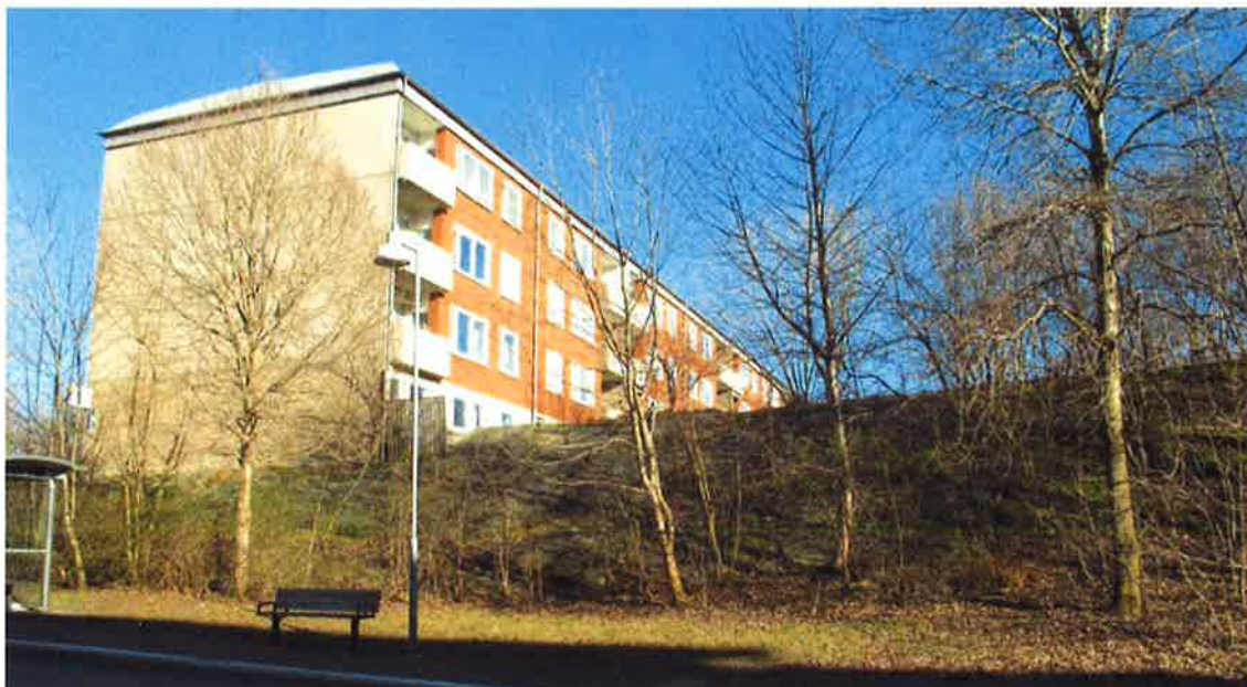
Befintlig fasad, utan fönster mot Ulfsparrégatan
