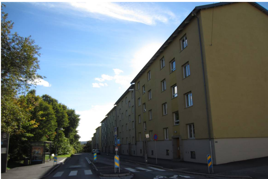
Befintliga lamellhus längs Ulfsparrégatan
