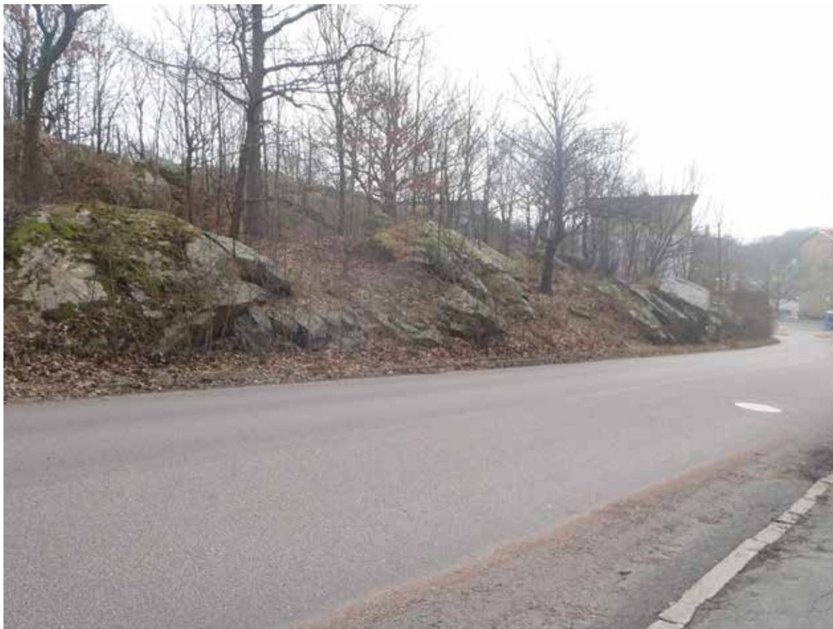
Foto 6. Från parkeringsplatsen vid Ulfspärregatan 11G vidtar bergskärning med sprickgrupp 1-3. Bakom bergskärningen löper en grund "dal" parallellt med gatan och bakom den vidtar ytterligare en bergslänt. Bild tagen mot sydöst.
