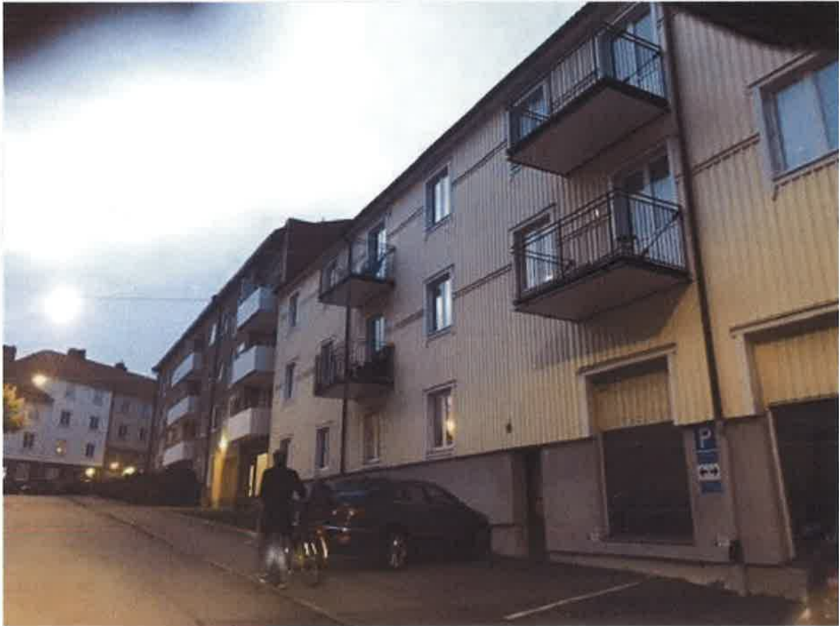
Nya balkonger på Lundgatan 1 har smidesräcke och kragar ut 1,4 meter (foto Bror Johansson AB)
