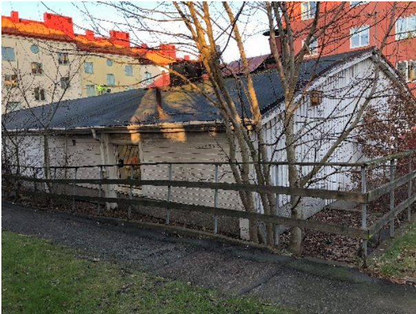
Figur 6. Befintlig byggnad inom planområdet.
