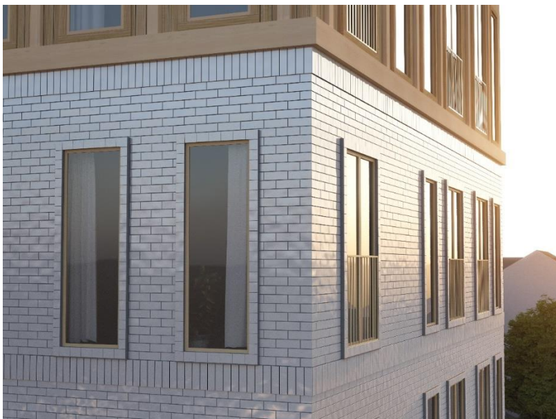
Figur 14. Illustration från Tengbom arkitekter som visar möjlig utformning med fasad av blankt fasadklinker eller glaserat tegel samt markerade fönsteromfattningar och franska balkonger med smidesräcken.
