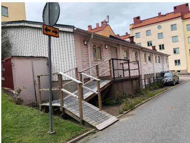
Figur 8. Befintlig byggnad inom planområdet.
