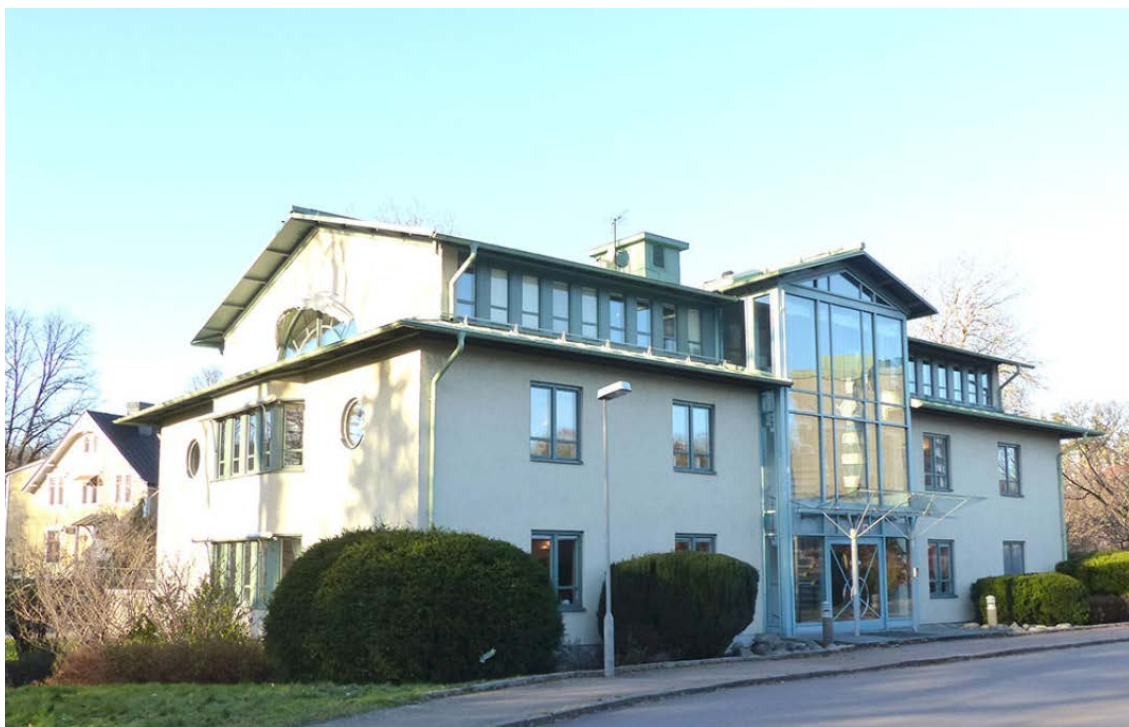
Foto av kontorshuset vid Prästgårdsgatan
