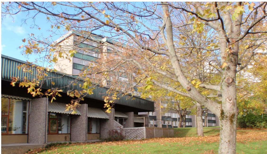
Foto av kontorsbyggnaden (före detta restaurang)
