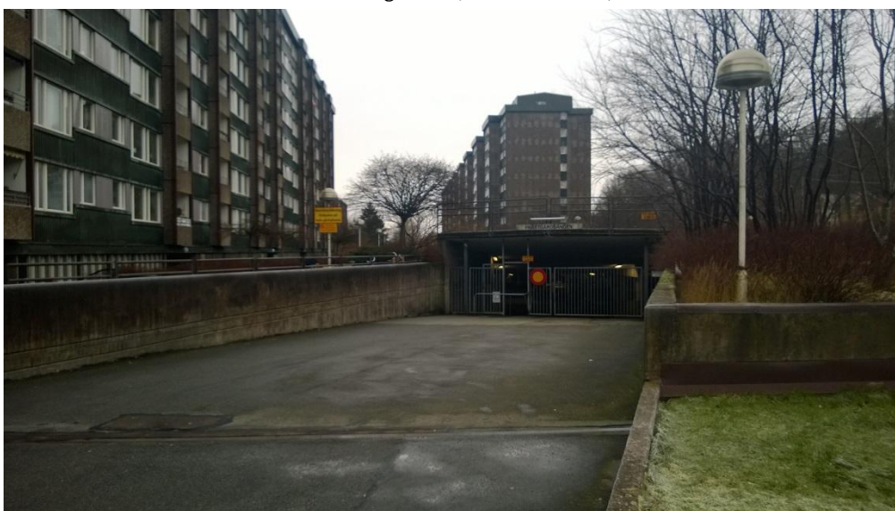
Figur 3. Nedfart till befintligt garage från Kärllundsgatan (foto: Ramböll).
