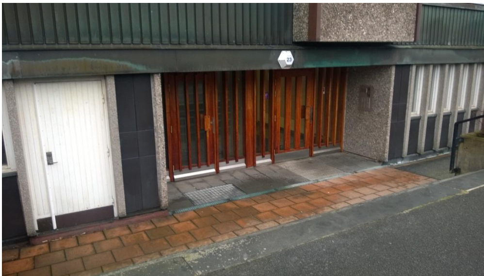
Figur 16. Lutning mot husets entré (foto: Ramböll).
