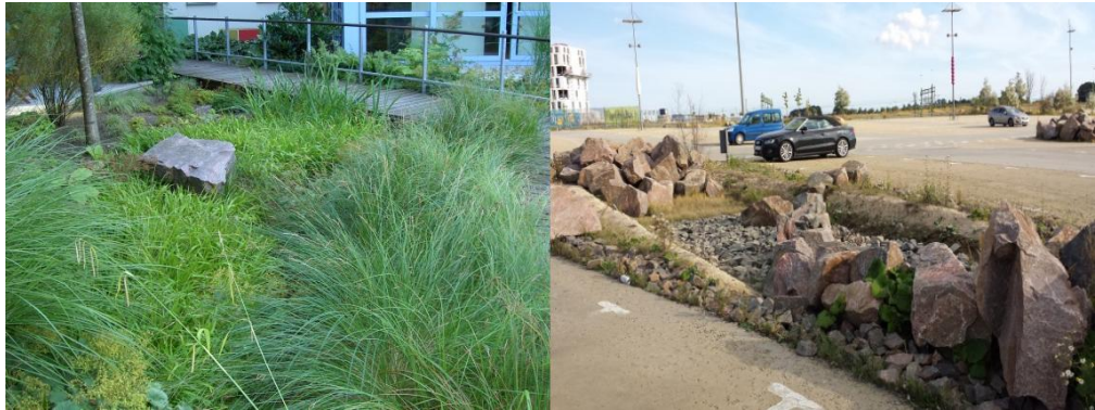
Figur 26. Exempel på utformning av växtbädd och öppen stenkista.
