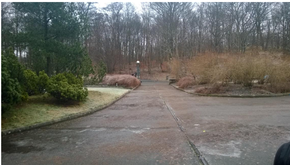
Figur 6. Innergårdarna avvattnas med hjälp av rännor som löper i öst-västlig riktning.
