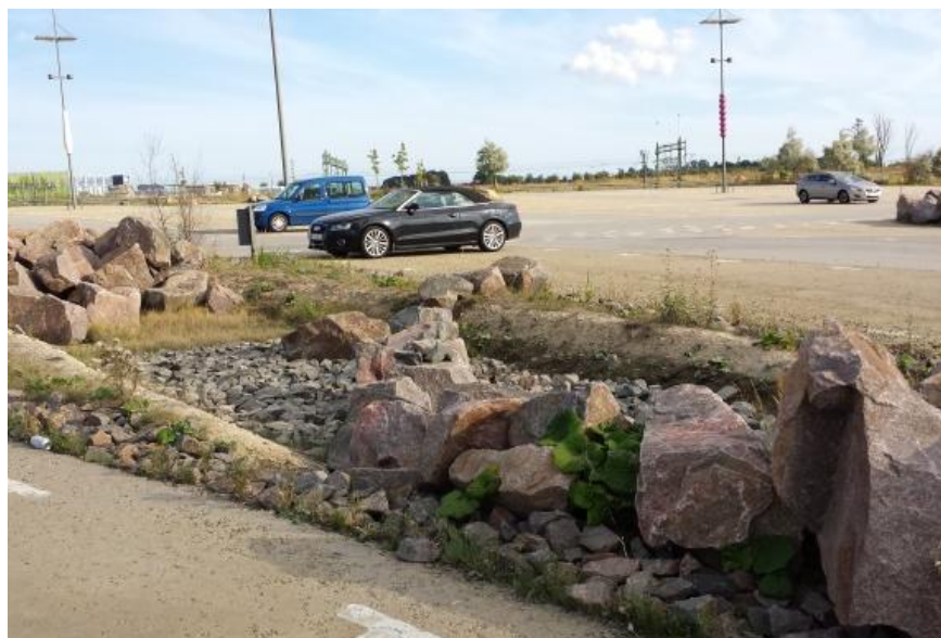
Figur 11. Förslag utformning av öppen stenkista - i torrt väder.
