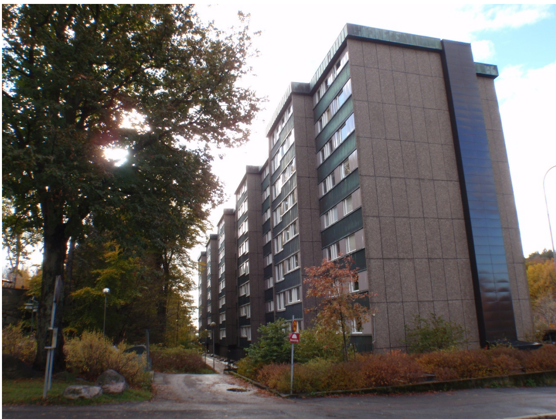
Foto av befintlig gavel mot Kärralundsgatan
