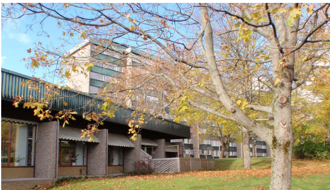
Foto av kontorsbyggnaden (före detta restaurang)
