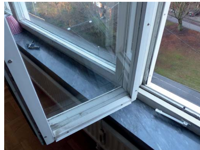
Fönstren har utvändigt klätts med plastlister, som sitter på två millimeters avstånd från bågen.
