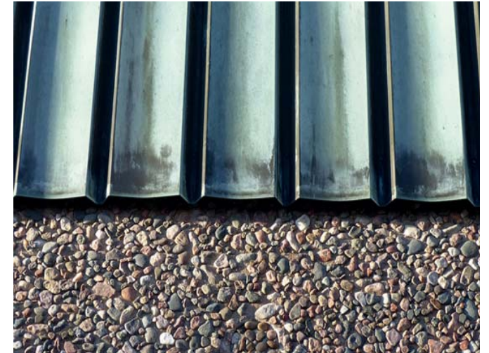
Ovan: Detaljbild på möte mellan dansk sjösten och korrugerad koppar. Bilden ger en uppfattning om den starka materialverkan som ges i området.
