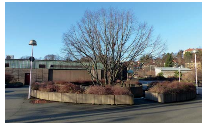
11. Nedan: Rund genomföring till garaget. Entrén till mataffären var tidigare i den igensatta delen av byggnaden bakom.
