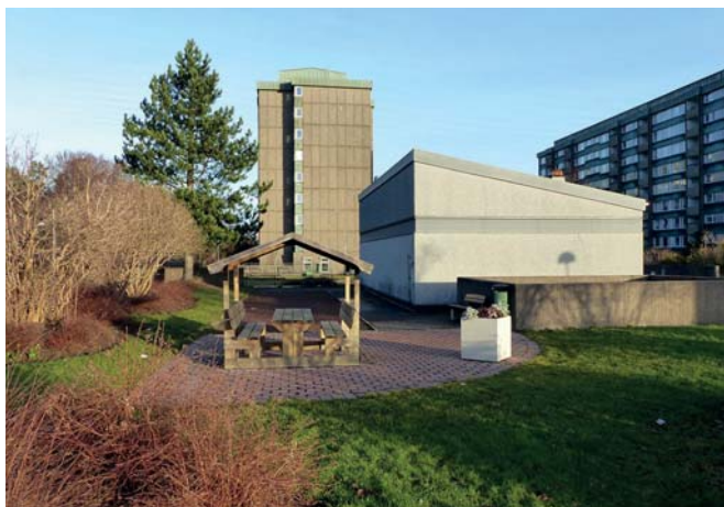
8. Ovan: Gårdens södra del med sopsugsanläggningen.
