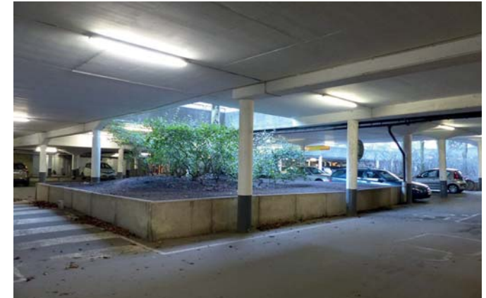
Ovan: Exempel på en av de ursparningar för träd och planteringar som genomfördes, och som än i dag utgör en kvalitet i såväl gårdsmiljön som garaget.
