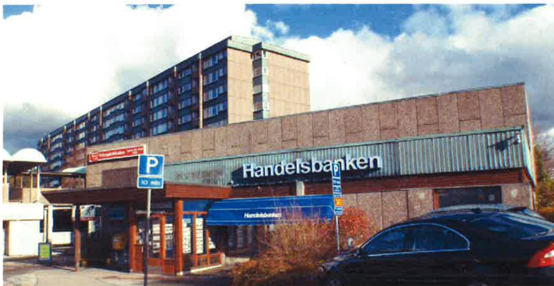
Foto av byggnad med bank och restaurang som föreslås rivas och ersättas med ny byggnad
