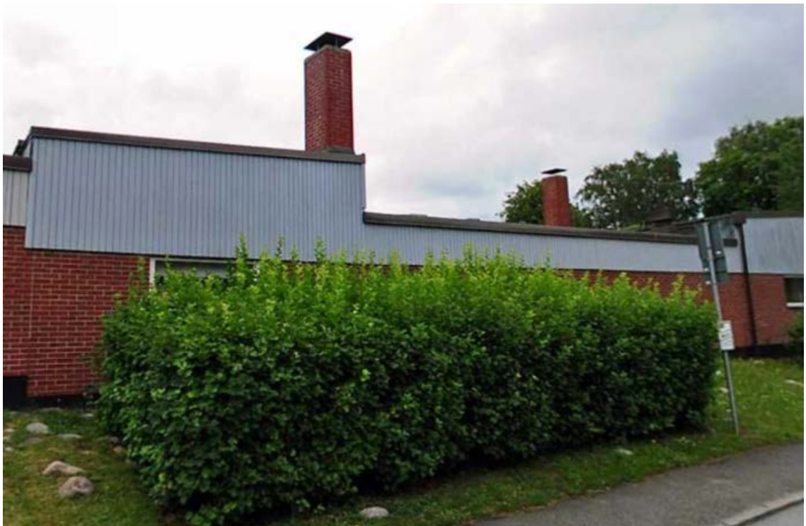
Fastigheten Lunden 70:5s fasad mot Prästgårdsgatan
