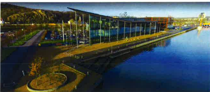
Kanalhuset från norr. Till vänster Pumpgatan
