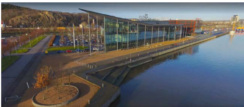
Kanalhuset från norr. Till vänster Pumpgatan
