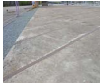
Befintlig betongbeläggning; linjalbäddar och kranspår
