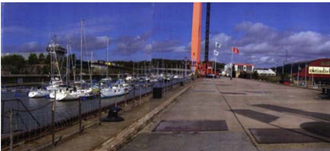
Dockan 2002 mot inre delen.
