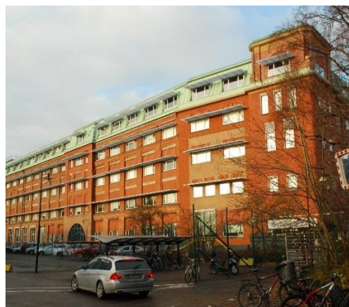
BC-fabriken "Nordkulan". Tidig bild i svart-vitt (bild ur Volvos historiska arkiv), befintlig utformning av byggnaden till vänster (foto Lena Knutson Udd, 2016).
