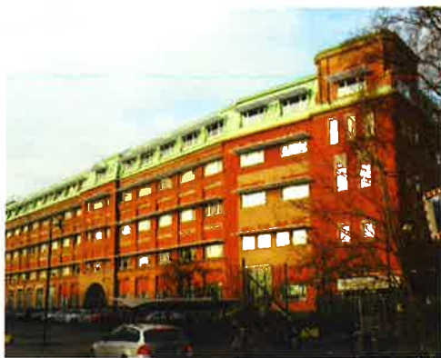
BC-fabriken "Nordkulan". Tidig bild i svart-vitt (bild ur Volvos historiska arkiv), befintlig utformning av byggnaden till vänster (foto Lena Knutson Udd, 2016).
