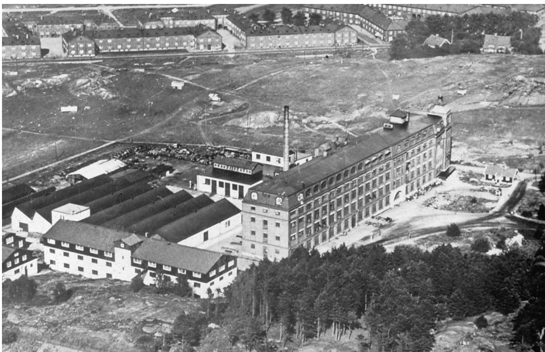
Ett flygfoto över Lundbyverket på 1920-talet där BC-fabriken i flera våningar är kringgärdad av lägre kontors- och verkstadsbyggnader. Bild ur Volvos historiska arkiv.
