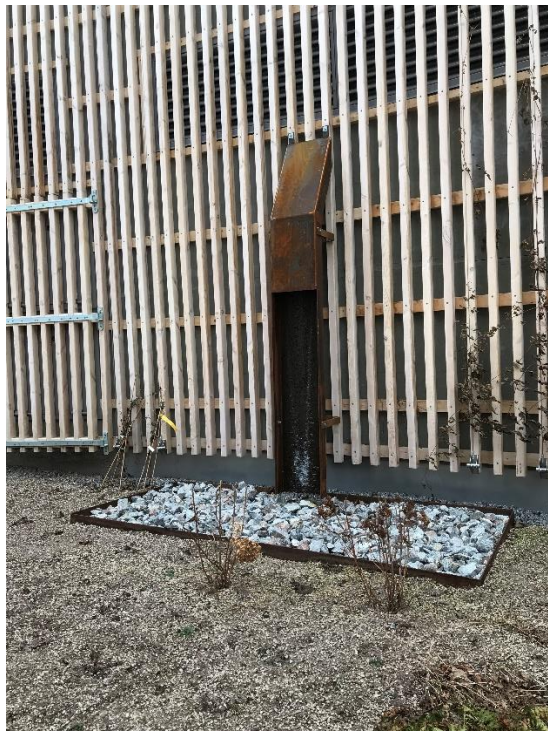
Figur 21. Förslag till avvattningslösning för tillkommande och befintliga takytor. Stuprör som avvattnas till regnbädd med krossmaterial. Exempel från Norra Djurgårdsstaden (2018)
