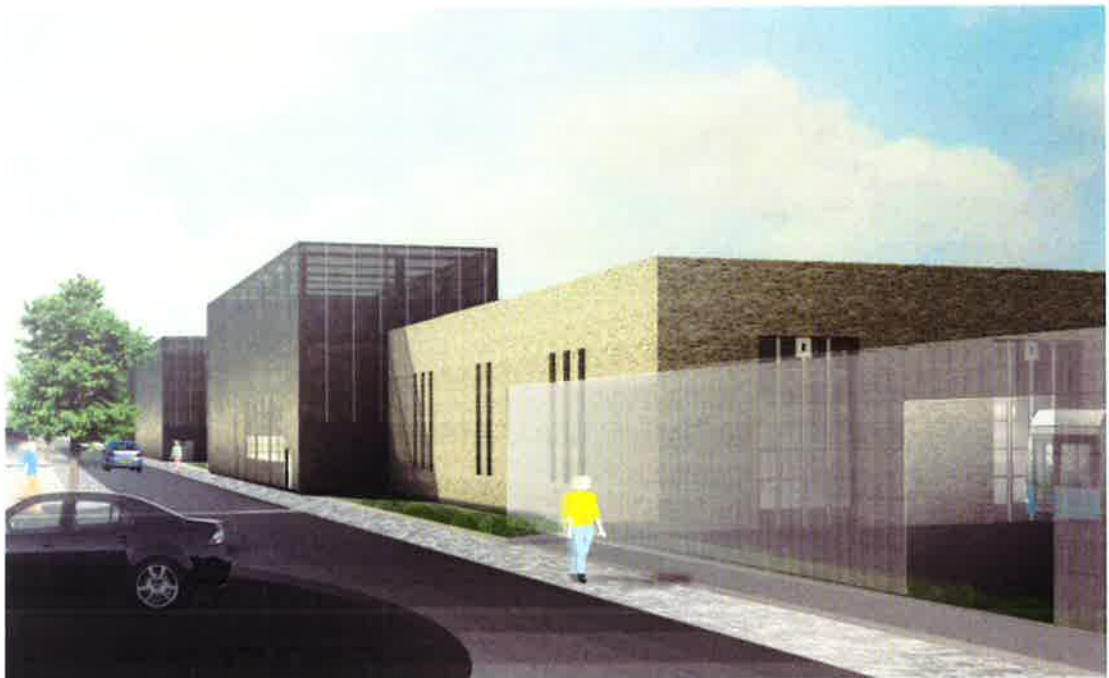
Drifhallen sedd från den nya lokalgatan (BBH arkitekter & ingenjörer, 2016).
