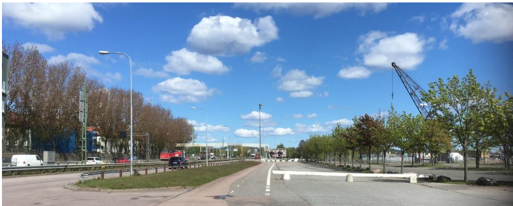
Figur 7 Lundby Hamngata med Lundbyleden och hamnbanan till vänster samt cykelbana och parkeringsytor till höger. Gångbana saknas i bilden.
