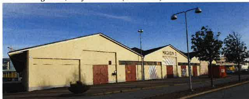
Foto 3 - Magasin D, sett från väster. (Norconsult)
