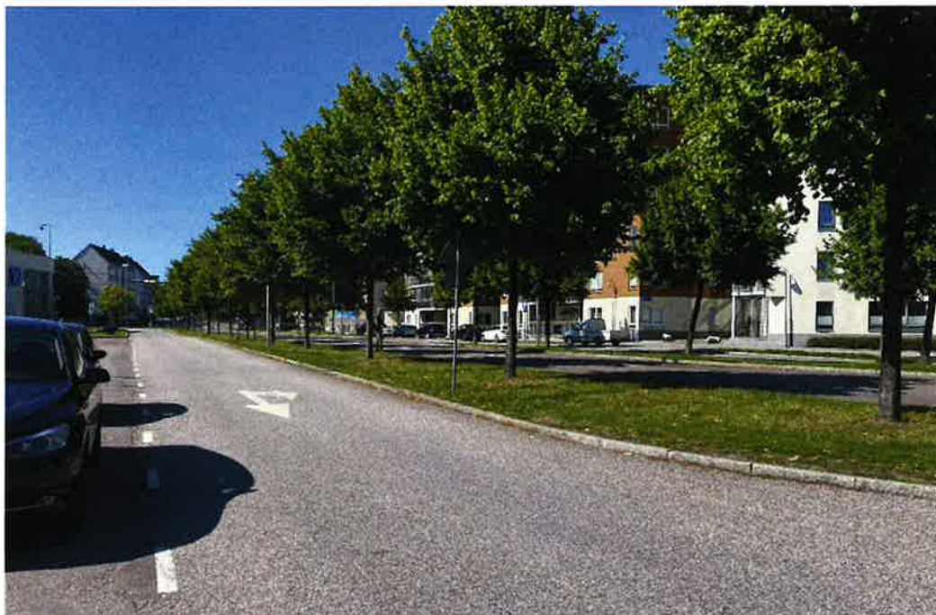
Trädrad mellan hållplats Lindholmen och vändslingan som påverkas av ny spårdragning.
