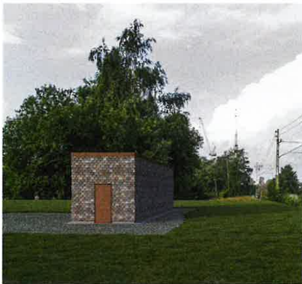
Teknikbyggnad vid "Knäcken" (PM gestaltning – likriktarstationer, Afry)
