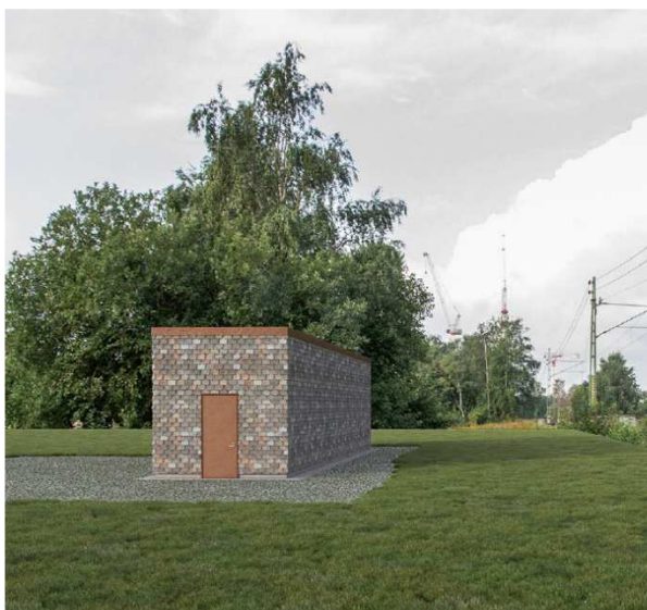
Teknikbyggnad vid ”Knäcken” (PM gestaltning – likriktarstationer, Afry)
