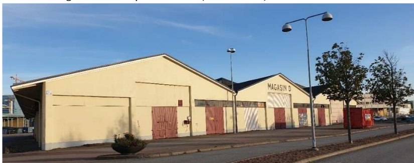
Foto 3 - Magasin D, sett från väster. (Norconsult)
