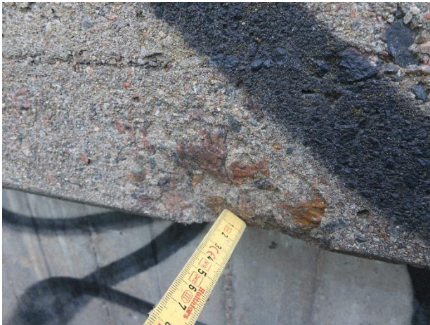
Figur 8: Krosskåda underkant samt utsida på sydöstra kantbalken.
