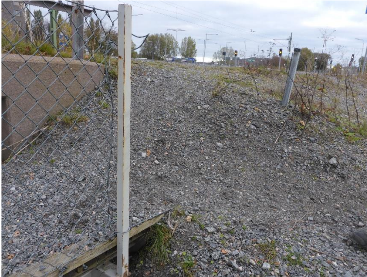
Figur 16: Stängselnät saknas på nordöstra sidan av gc-bro.
