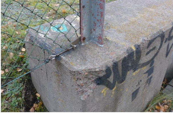
Figur 7: Krosskåda sydvästra hörnet på sydöstra kantbalken.
