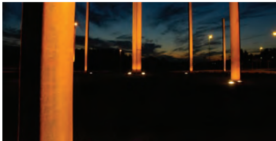
Pelarsalen med pelare i cortenstål i vändslingan belyses likt referensexempel underifrån med markstrålkastare.
