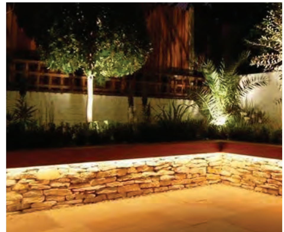
Belysning integreras i murar längs gång- och cykelpassager över Lindholmsallén samt vid Pumpgatans hållplats. Referensexempel visa släpljus som integrerats i ovasida av mur.
