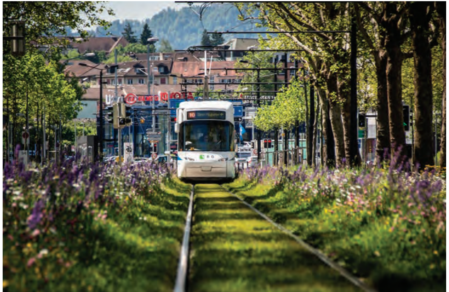
Inspirerande referensbild från spårväg i Zürich med vackert blommande örtskikt som omger och bäddar in det gröna spårområdet. Bild: raegi.ch
