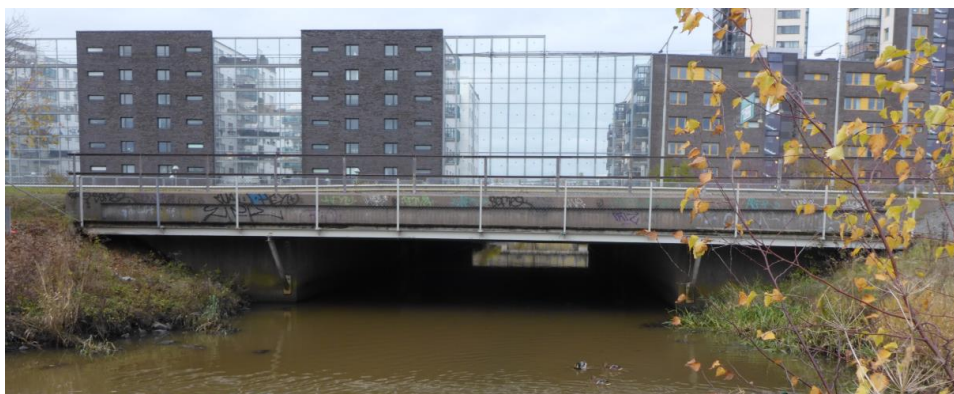
Figur 1.2 Bro 1480-1672-1, Lundby Hamngata.
