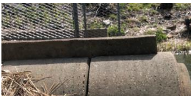
Figur 3.2 Längsgående balk ovan betongtrummor.
