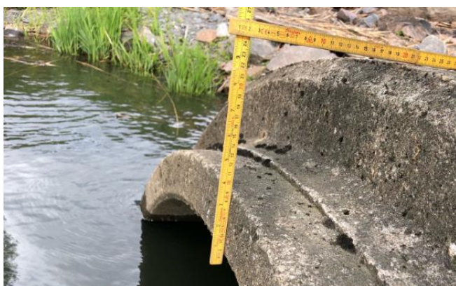
Figur 3.1 Betongtjocklek trumma.
