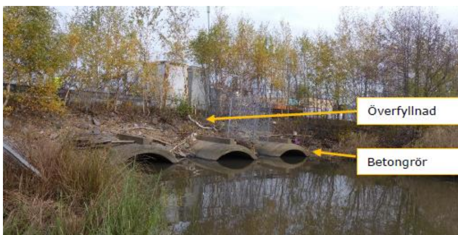
Figur 1.3 Betongrörbro, Lundby Hamngata.
